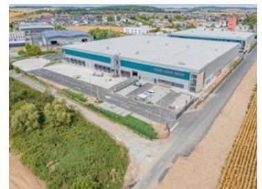
Der Logistikpark Langenselbold A45 verbindet moderne Flächenqualität mit leistungsfähiger Infrastruktur und nachhaltiger Gebäudetechnik
