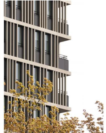
Die Fassaden des Projekts sind mit hell und dunkel eloxierten Aluminiumplatten verkleidet.
