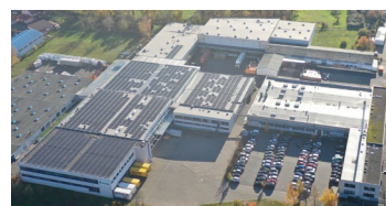
PV-Anlage auf dem Dach der Kopp Zentrale in Kahl am Main
